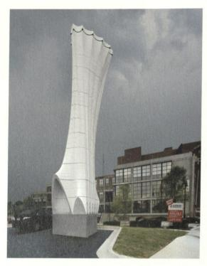
石法。可展表面(具有讽刺意味的是,其也适合于众所周知的在轻薄表面材料中占据着重要地位的 "可展开曲面")是通过最小限度地扫掠线条定制石刻的方法,这些线可被拉平,否则便从三维几何变为二维制图,这是众所周知的显著特征之一 ②,[1]。通过提炼这些原则,我们可以将这些假设的线条想象为物理的和CNC的设备——密歇根大学陶布曼建筑与城市规划学院的一个定制的七轴机械自动控制的热钢丝切割器。传统技术与当代材料和建造方法的结合形成了下述两个项目中所展现的制图和建造的相互关系。
